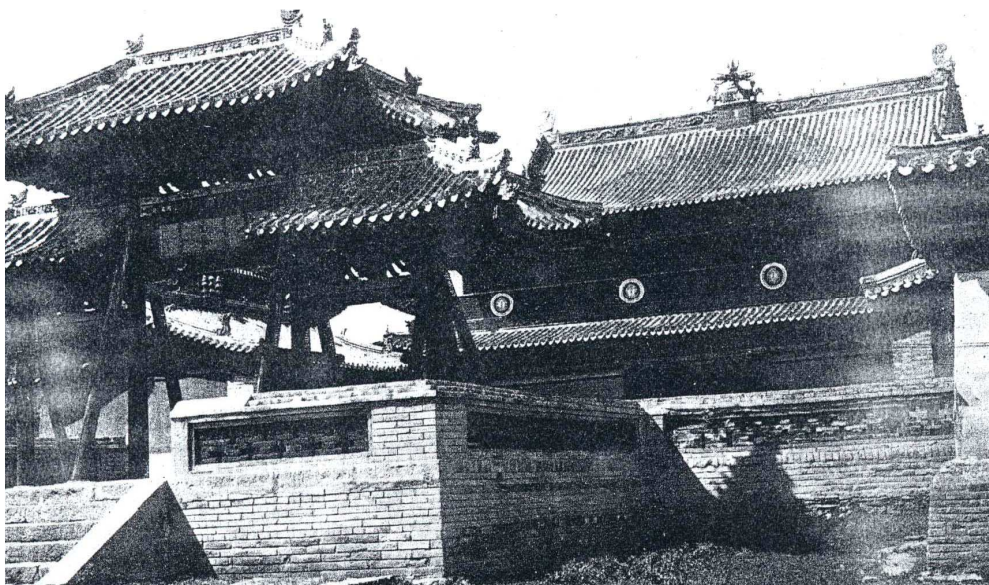
Obr. 3 Hlavní vchod do kláštera Erdenedzú
